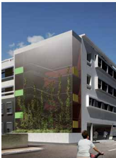
Clinique de la Sauvegarde à Lyon (69) Architecte Hans Alozie
