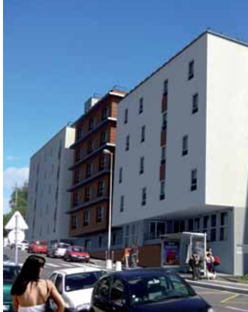
EHPAD Bertrand à Lyon (69) Architecte Yves Crocier
