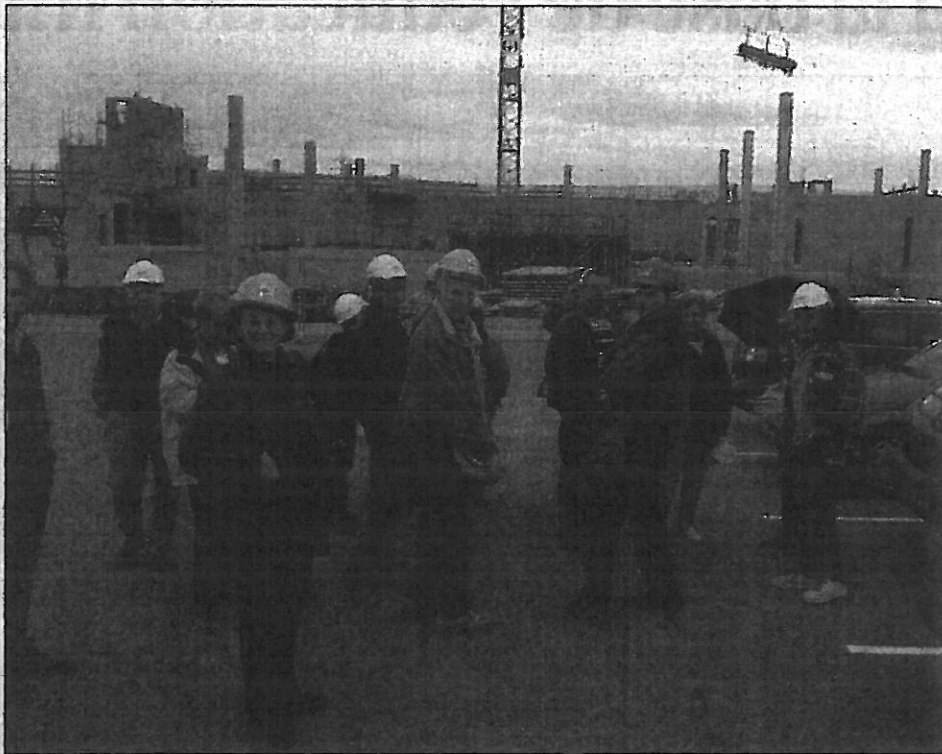
20 visiteurs, accompagnés par des représentants de l'entreprise Floriot, avaient accès aux 20 000 m 2 des futurs locaux commerciaux et des parkings aériens et souterrains / Photo Danielle Mantel
